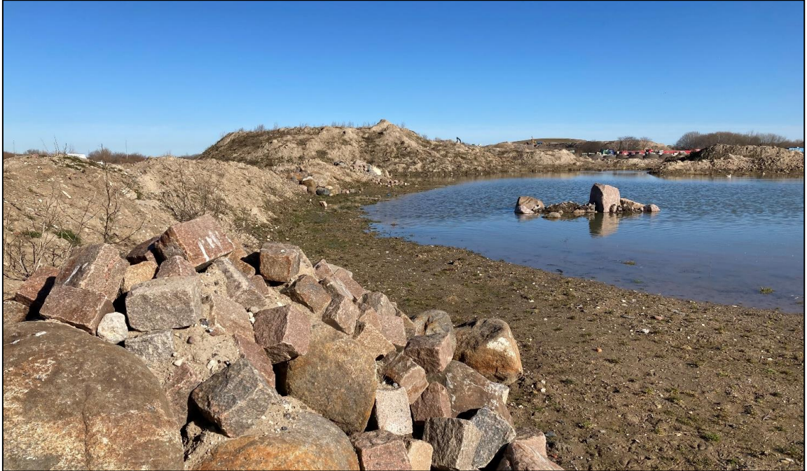
Figur 6-1. Eksempel på nyanlagte (2022) yngleområder (vandhuller) og rasteområder (stenbunker) for grønbroget tudse i området øst for Tunnelfabrikken i Københavns Nordhavn, marts 2023. Foto Søren Ferdinand Hansen.
