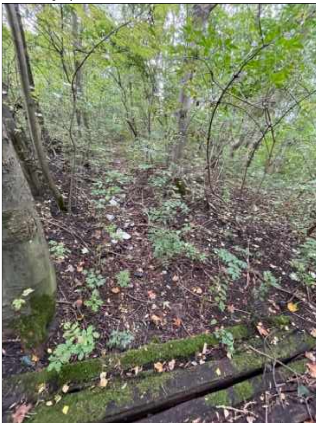
Drængrøft mod nord med plankebro.
