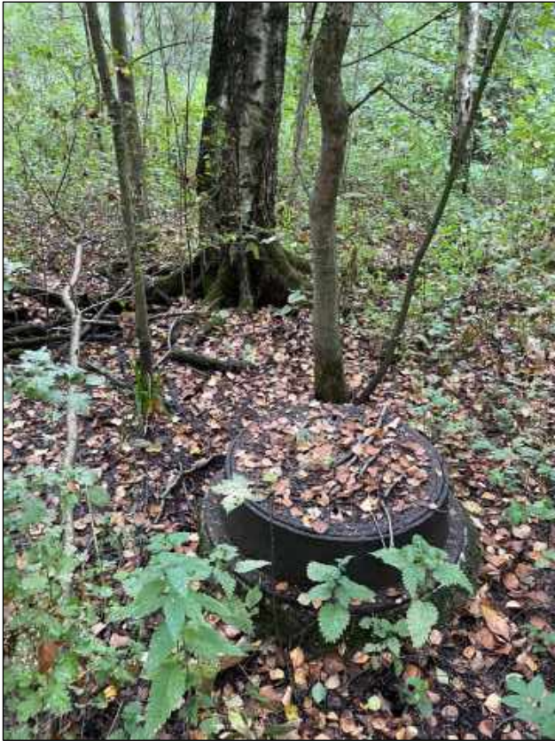
Dræbrønd tæt på dokumentationsfelt..
