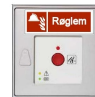
Figur 5.7.0.1.a: Eksempel på aktiveringstryk for røglem
